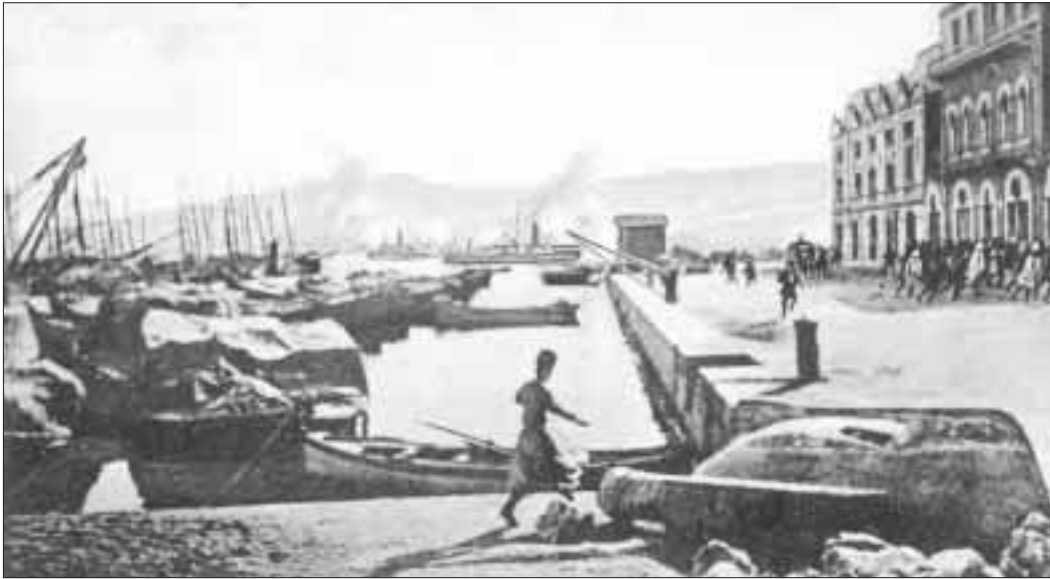
● مرقا بيروت أثناء القصف الإيطالي
